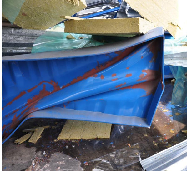
Figur 6.24 Skruven mitt på balkhöjden har bidragit till bucklingen (Objekt 105). Balken har inte kunnat rotera fritt utan att föra in spänningar i livet.
