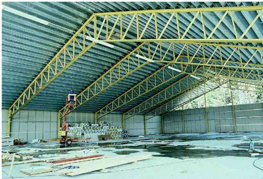
Figur 11.1. Figuren visar en takstolstyp kallad nockat sadelfackverk.
