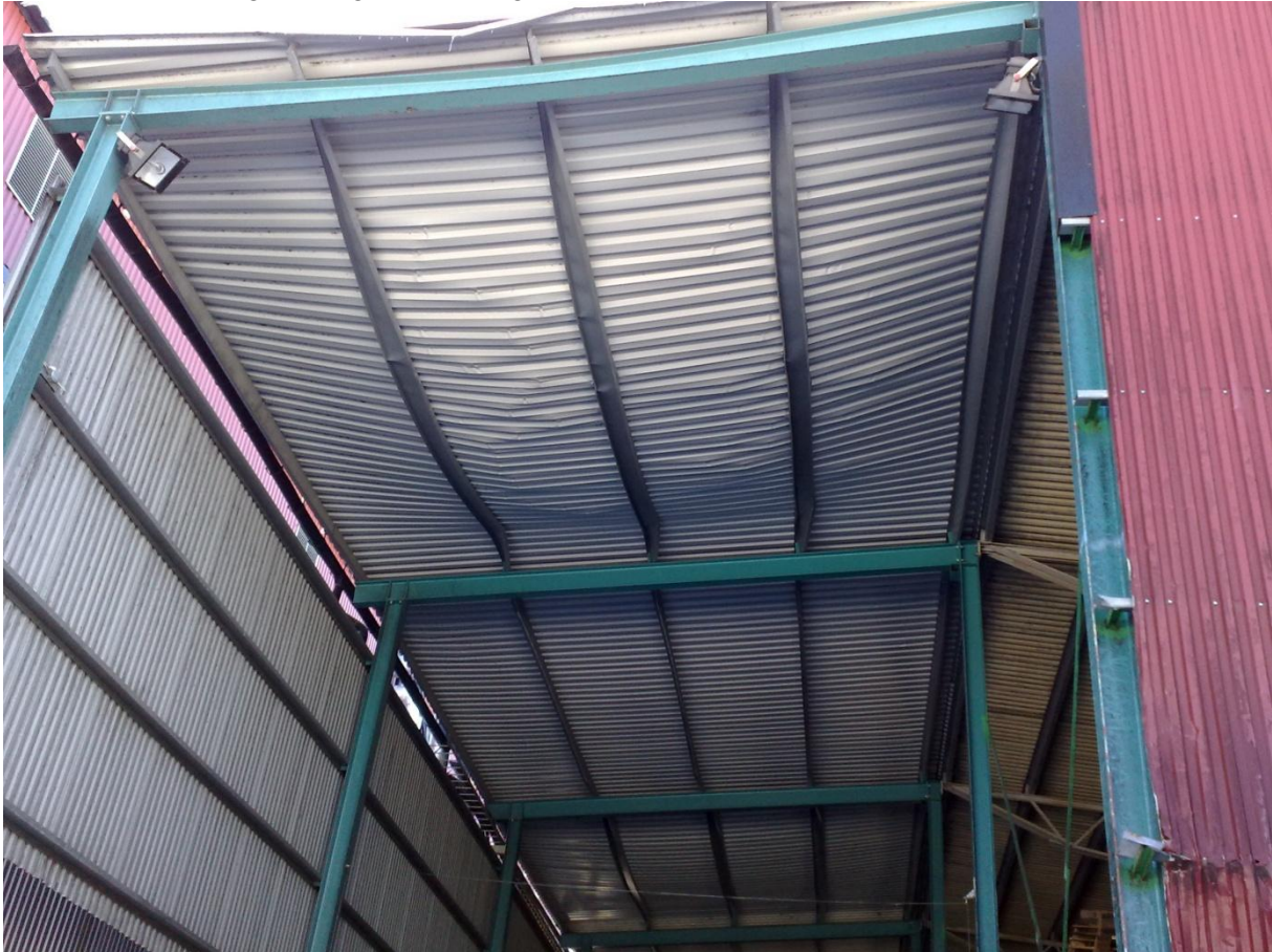
Figur 6.26 Z-balkar vända med överflänsen nedåt i takfallet. Takåsarna har vridit sig i takfallets riktning.
