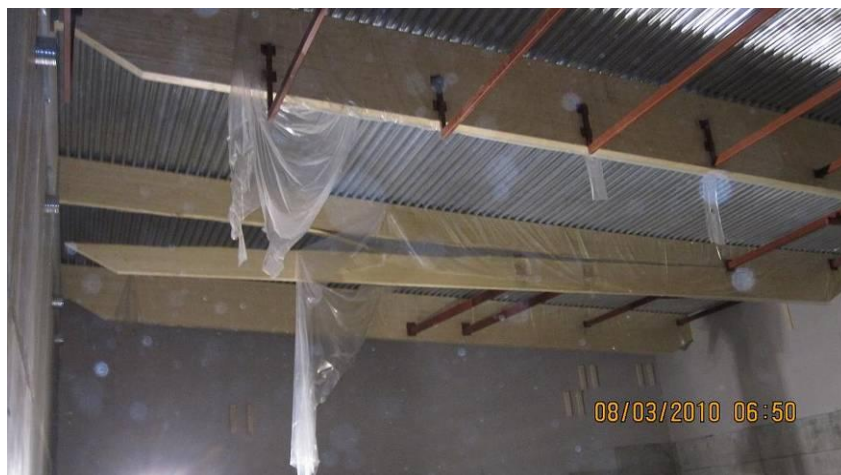
Figur 6.7 Havererat tak balk med urtag i balkände med snedsågad underkant.
