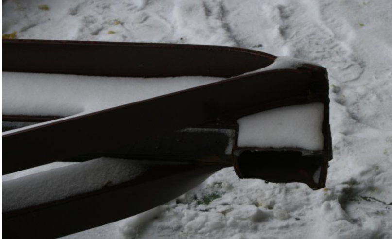
Figur 6.22 Takbalksupplag som legat på momentstyvt upplag och som böjts loss från fotplåten (Objekt 18). Takbalken har endast kunnat rotera en begränsad vinkel.
