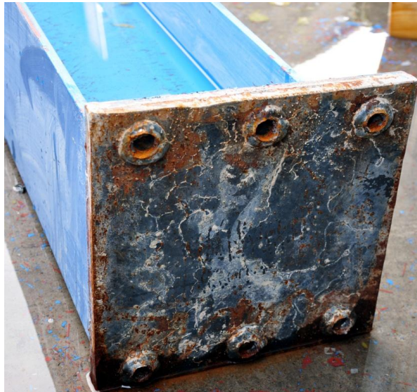
Figur 6.25 Pelarfot med bristande svetsning av förankringsjärn till svetsplåten/fotplåten (Objekt 105). Pelaren sitter märkbart förskjuten i sidled. Svetsplåten ser med tanke på järnens placering i förhållande till pelaren också ut att var vriden 90° fel. Lastkapaciteten för denna pelare var betydligt lägre än avsett liksom svetsplåtens förmåga att ta upp laster från stommen.
