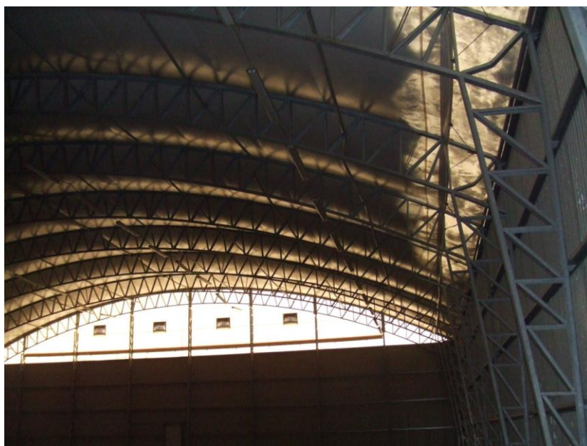
Figur 6.19 Stabilitetsbrott i ramhornets tryckta diagonal (övre högra hörnet).
