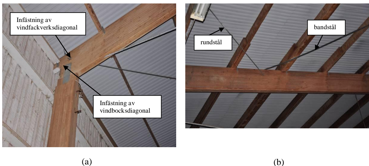
Figur 6.30 Ridhus i Uddevalla. (a) Infästningsdetalj av vindfackverksdiagonal och vindbocksdiagonal. (b) "knutpunkt" i vindfackverk.
